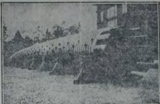
Montaje de un caño continuo de madera
