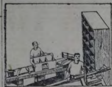
Obreros que trabajan en una instalación
