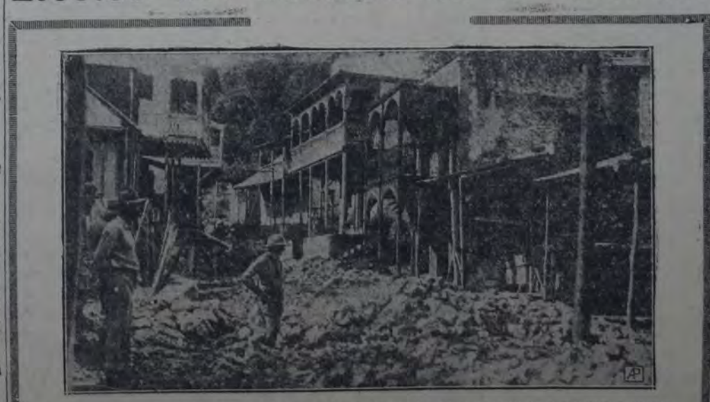
EL GRABADO NOS MUESTRA EL ESTADO EN QUE QUEDO LA CALLE PRINCIPAL DE LA POBLACION DE MIRAGONE, EN HAITI, DESPUES DE SUFRIR LOS EFECTOS DEL RECIENTE HURACAN QUE AZOTO LA REGION DE LAS ANTILLAS, DEJANDO DETRAS DE SI COSECHAS ARRUINADAS, MISERIA Y HAMBRE. SE CALCULA QUE HOGAN A CIEN MIL LAS PERSONAS QUE HAN QUEDADO DESAMPARADAS
